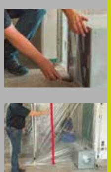
Le système anti-poussière ToolPower se compose d'un mur anti-poussière, d'un purificateur d'air et de la dépression nécessaire sur le lieu de travail. La dépression sur le chantier empêche la poussière de s'échapper par de petites fissures dans les pièces adjacentes. Avec le système anti-poussière ToolPower, la maison reste 100% exempts de poussière.
